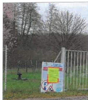
sur le site du captage
